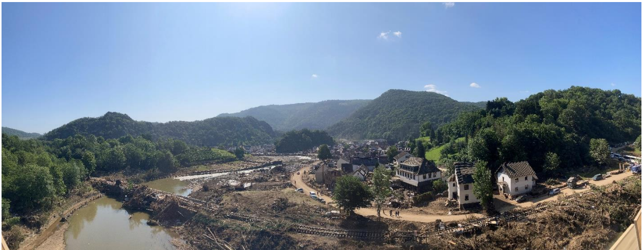
Abb. Schadenssituation im Ahrtal Juli 2021 | EDAC (H. Maiwald)
