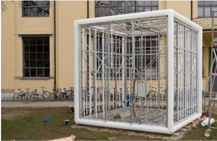
Abbildung 2: Aluminiumgerüst des Systems2040 der Fa. Göpfert, Weimar
