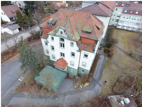
ABB. 10 Ansicht des ältesten Gebäudeteils des Krankenhauses
