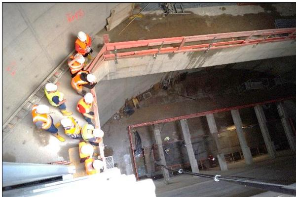
Betonierarbeiten an der Sohle des Pumpwerkes. Ein Treppenturm mit 220 Stufen führt in die Tiefe.
