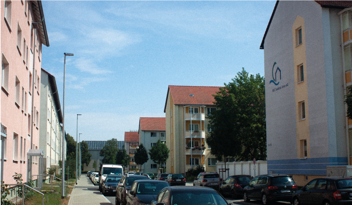
Abb. 19: Straßenraum in Jena-Nord als Beispiel des Stadtstrukturtyps: Block- und Plattenbauweise. Eigene Darstellung
