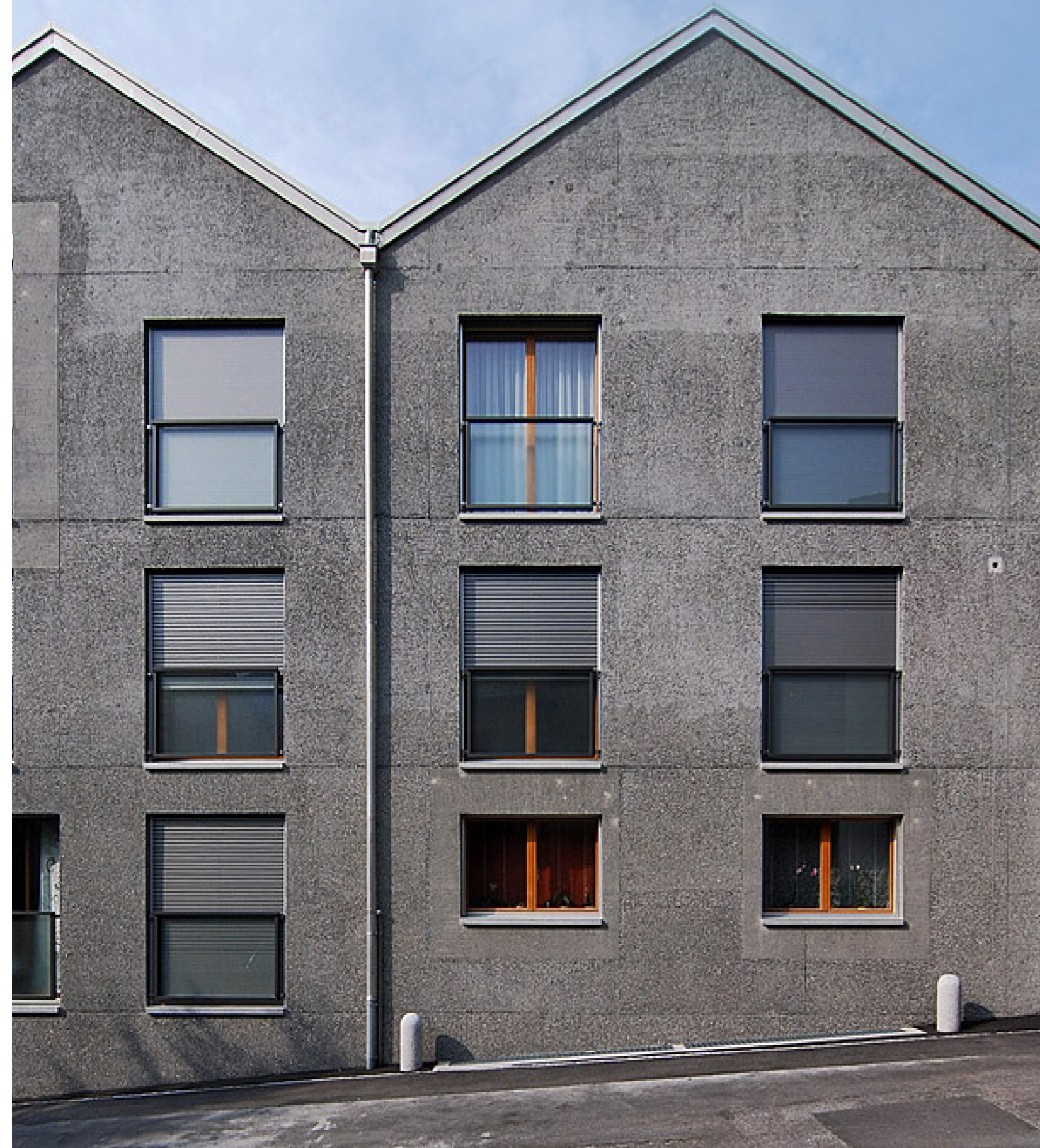
Abb. 1 Bürgerhaus in Haldenstein(2005 - 2008), Miroslav Šik ,Fassade
