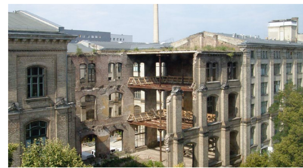
Abb. 02: Die „Ruine“ vor Beginn des Wiederaufbaus
