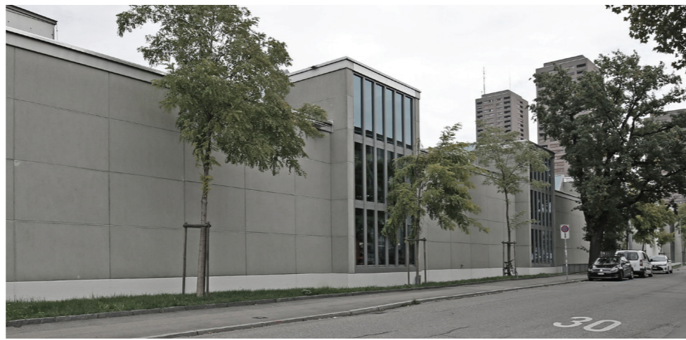
Abb. 07: Das gegenüber der Straße liegende Tramdepot
