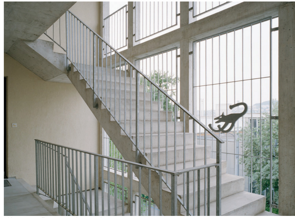
Abb. 13: Das offene Treppenhaus von innen
